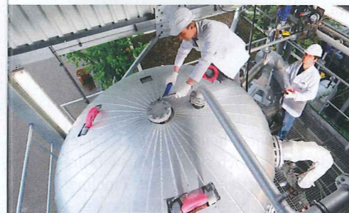
HotReg-Teststand des Deutschen Zentrums für Luft- und Raumfahrt in Stuttgart: Simulierter Druckluftspeicher
